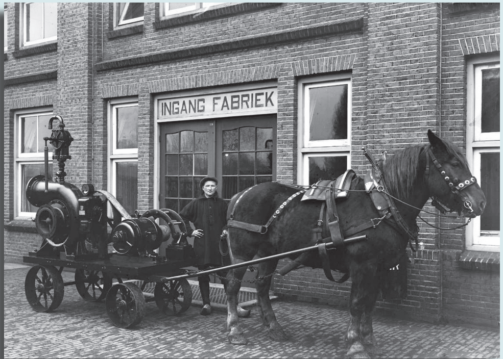
Centrifugaal pomp met EFF1930 Heemaf SKA motor (bron: www.holechistorie.nl )
